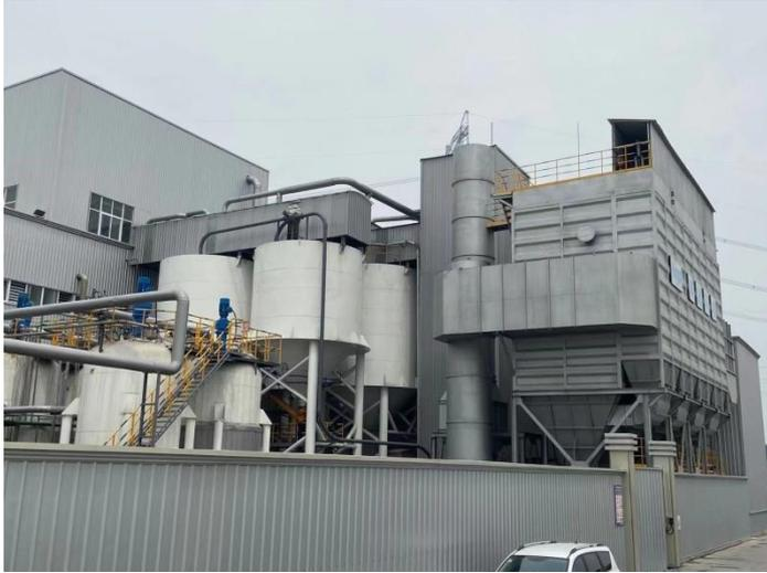
卸料破碎工段除尘器
